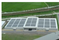
太陽光第二発電所
