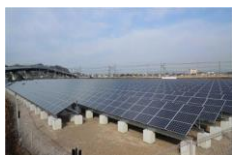
太陽光第一発電所
