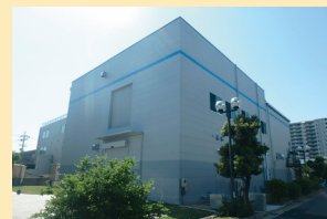
大阪工場 第二技術実験棟
