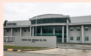
ホーチミン第2工場(ベトナム)
