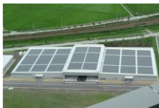
太陽光第二発電所
